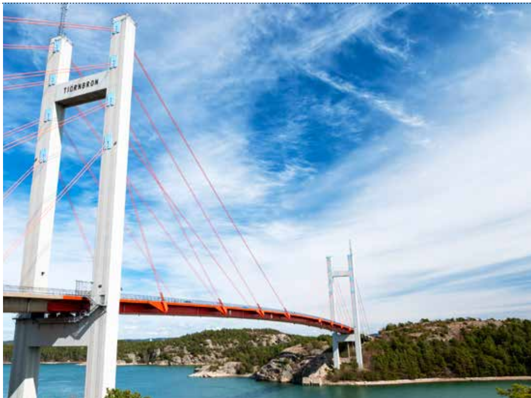
Svevia har utfört ett kabelbyte på Tjörnbron, något som aldrig tidigare har gjorts i Sverige.
