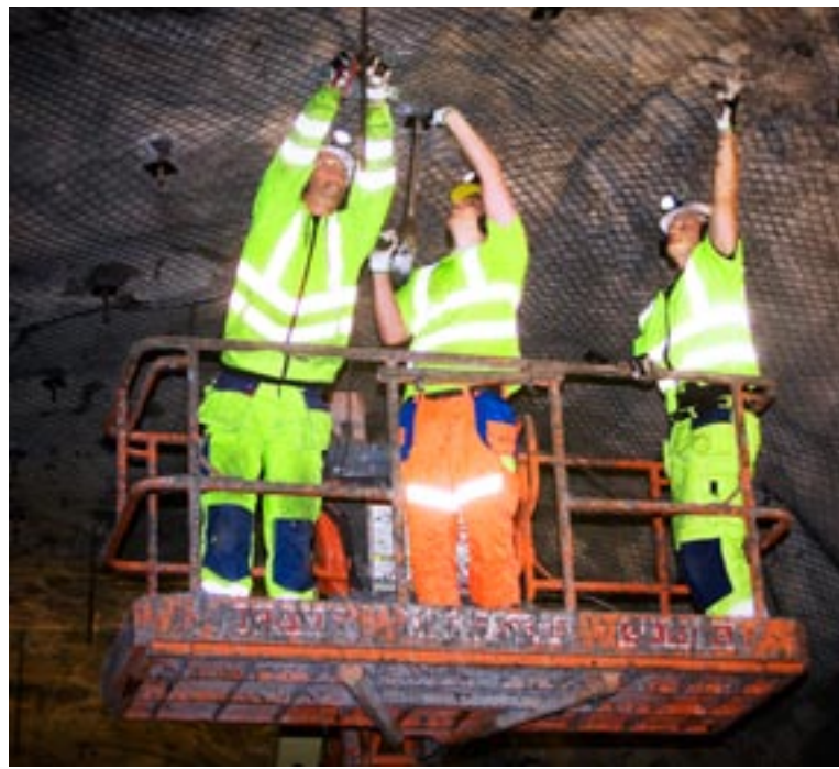
Tunneln kläs med bergnät för att inte sten och betong ska släppa.
