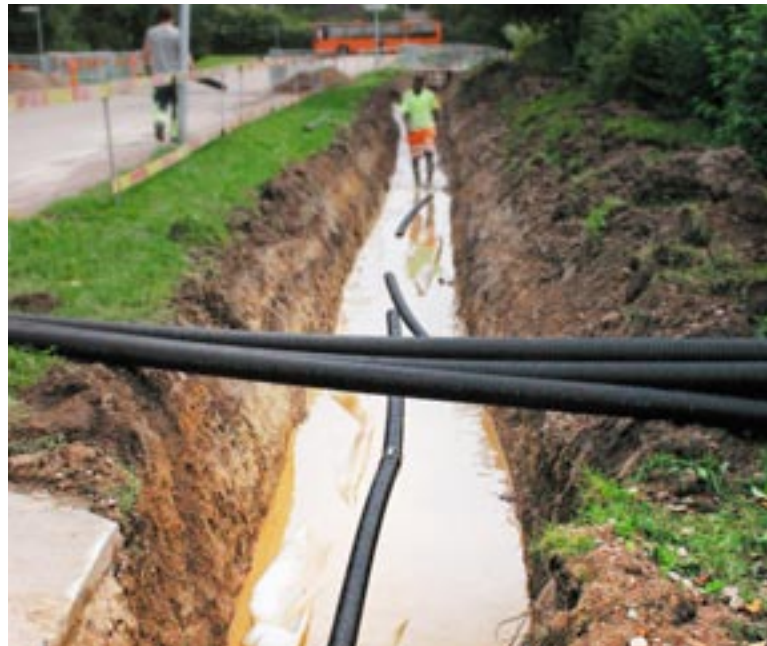
Ett rejält skyfall vattenfylde en av rörgravarna. FOTO: CHRISTER BERGSTRÖM
